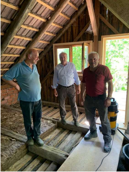
Mitte Mai 2024: Beginn der Arbeiten mit dem Abbruch des Bodens und Besuch auf der Baustelle von Bürgermeister Hermann Hammerl (Mitte)
